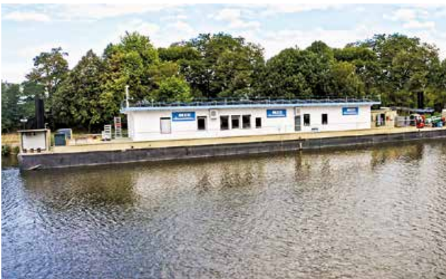
MSG Bunkerstation Luisa
